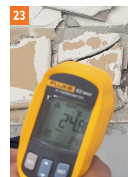
Foto. 22, 23 Geoflex Express. Teplota povrchu obkladového prvku v priebehu 5,5 hod. tuhnutia bola stabilná i pri 3 mm vrstve nepresiahla 23,2°C, v prípade 15 mm – 24,9°C, tzn. bola maximálne vyššia o 4,7°C ako okolitá teplota (hydratačná teplo). To dokazuje, že hydratačná reakcia postupuje stabilne.
