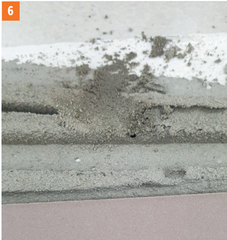
Foto. 4, 5, 6 Geoflex Express. Skúška tvrdosti lepidla vykonaná na zavädnutých „zuboch“ po 1,5 hod.: silný tlak spôsobuje rozdrvenie malty, farba pri prelomení je stredne šedá. Dlažbu je možné zaťažiť, je možné ju tiež začať škárovať.
